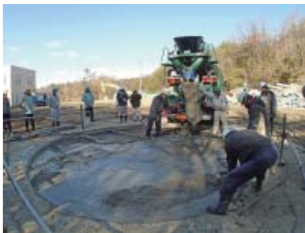
東濃鉱山 第2立坑坑口の閉そく作業
